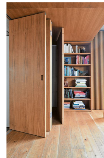
Eine Falttür aus Eiche trennt den Schlaf- vom Wohnbereich ab
