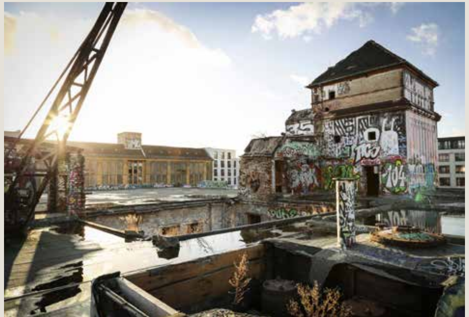
Das ehemalige Kühlhaus der Norddeutschen Eiswerke A.G. wird im Rahmen der Sanierung und Entwicklung des Grundstücks Köpenicker Straße 40/41 vor dem Verfall bewahrt. Foto: TROCKLAND
