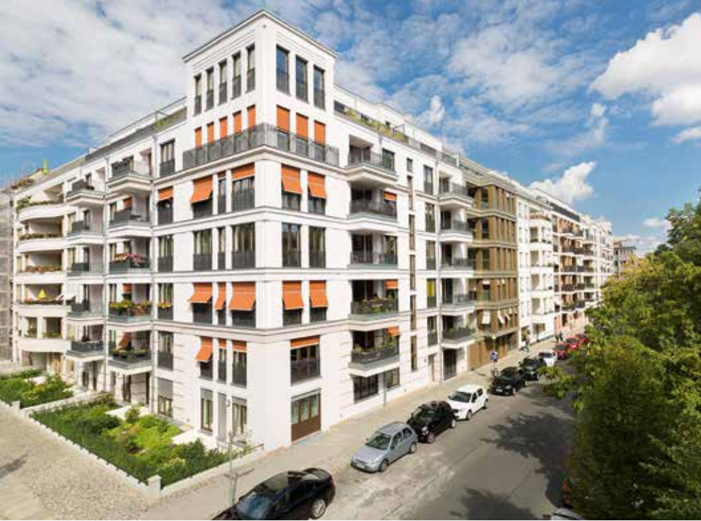
Zillegärten heißt das Projekt im Herzen von Alt-Charlottenburg mit 72 Wohnungen, die sich auf fünf individuell gestaltete Häuser verteilen. Quelle: BAUWERT AG
